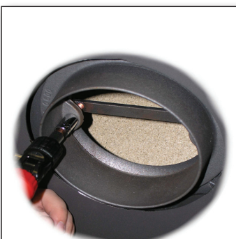
Fig. 8 Sørg for, at røgtuden sidder centreret og spænd herefter boltene
