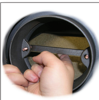
Fig. 7 Spænd røgtuden fast bag på ovnen med holderen eller bolte.
